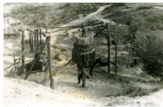
Extragerea „primitivă” a petrolului direct din puț cu hârdaiele (cu hecnă, sau cu crivac)
