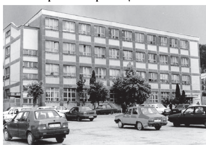
Clădire în proprietate, Strada Traian nr. 233, Câmpulung-Muscel
