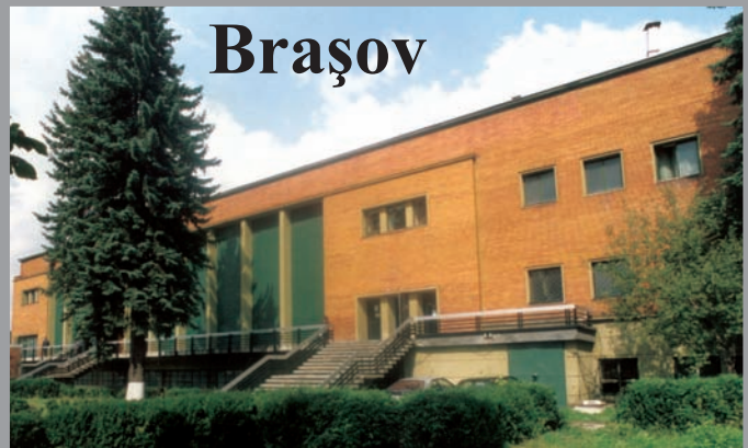
Clădirea în proprietate din Brașov, Str. Turnului nr. 5
