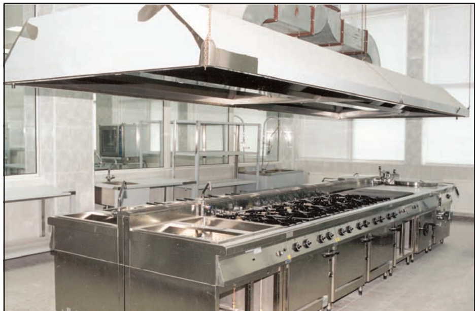
Aspect din bucătăria cantinei
